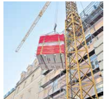
Die Baubranche erhält weniger Aufträge. Foto: AMH/Falk Heller
