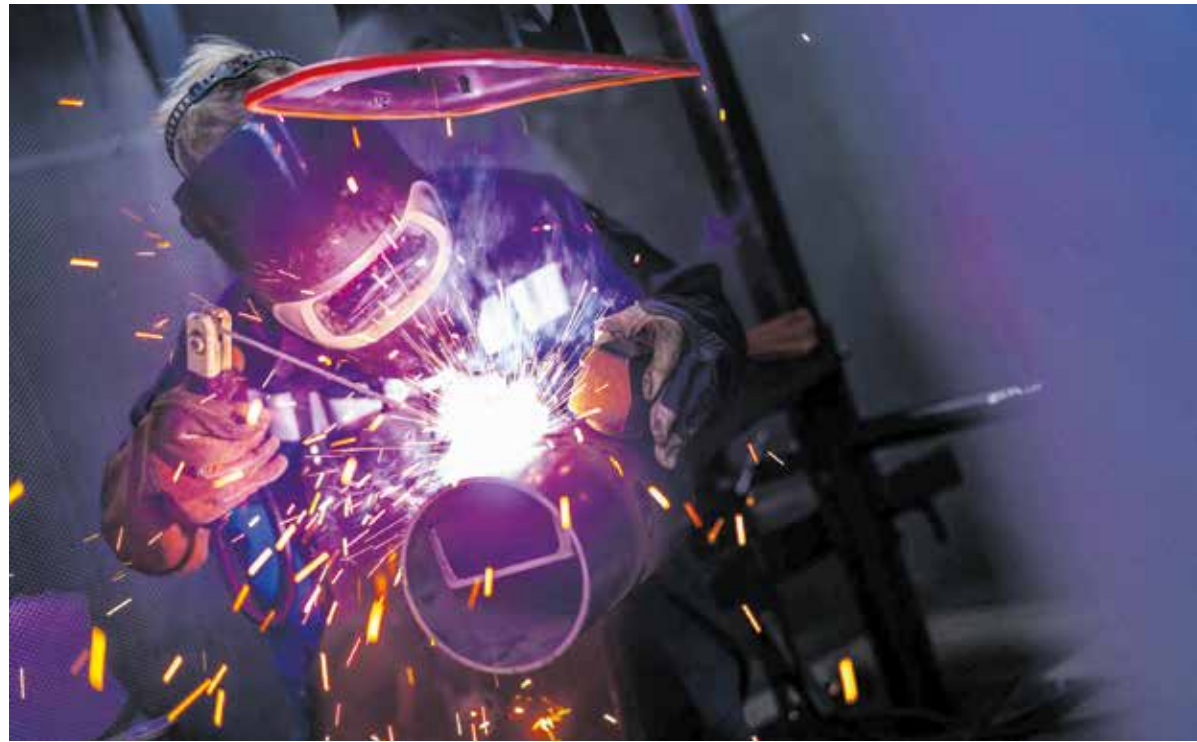
Mit der Einführung der DIN EN 1090 haben sich die Anforderungen für das Herstellen bzw. Inverkehrbringen von tragenden Stahl- und Aluminiumkonstruktionen im bauaufsichtlichen Bereich drastisch geändert. Die Zertifizierungsstelle berät. Foto: André Wirsig
